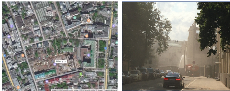
Рис 2. Схема расположения пункта наблюдений ИФА РАН и территории, на которой осуществлялся демонтаж (снос) научно-производственных зданий (слева) и фотография «пыльной бури» в Пызёвском переулке (справа). Fig. 2. Scheme of the location of IAP RAS observation point and the territory where the dismantling (demolition) of scientific and industrial buildings was carried out (left) and a photo of the "dust storm" in Pyzhevsky Lane (right).
